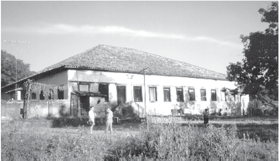
fig.2 -Vista lateral esquerda da Sede da Faz. Monte Serrate em 3 de maio de 1997
